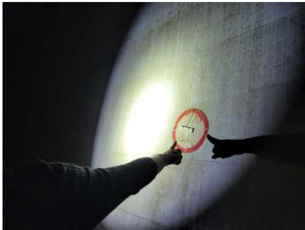
내벽 균열 관리
